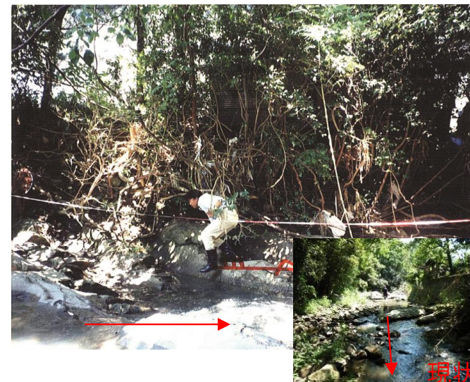
④平成7年豪雨被災写真（中山橋上流）
