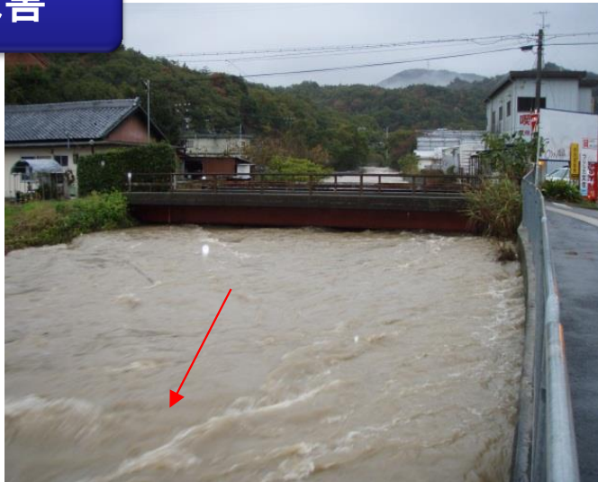
①平成21年11月豪雨写真 （南海橋下流付近）
