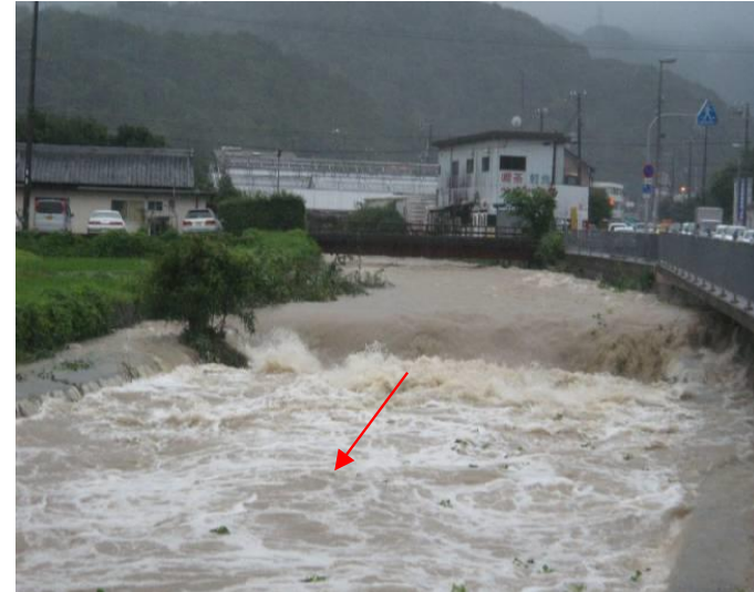
②平成22年7月豪雨写真 （南海橋下流付近）
