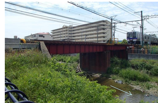
南海本線橋梁
