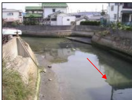
【新王子川橋上流】
