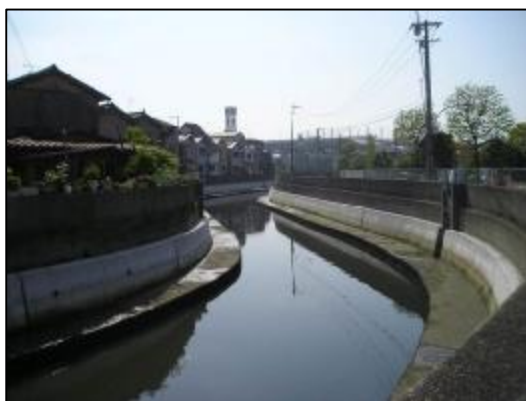
二級河川王子川（小高石橋付近）
