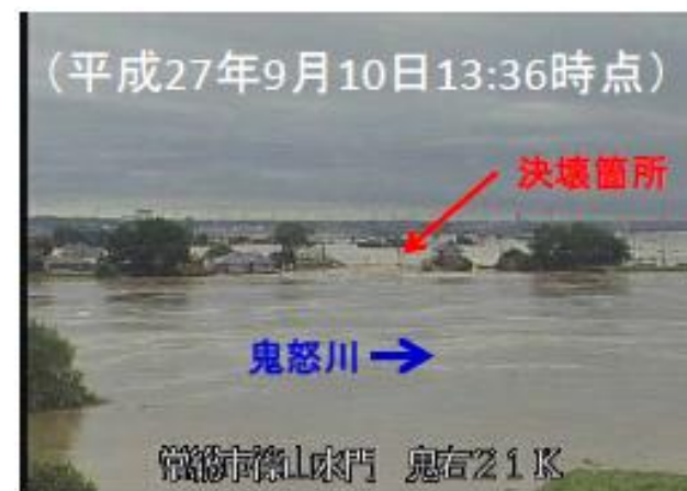
被災状況(対岸より撮影)
