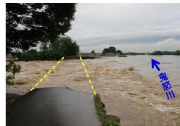
被災状況(拡大写真)
