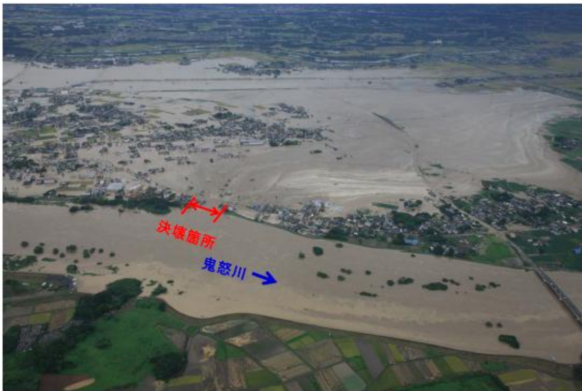
被災状況(全景写真)
