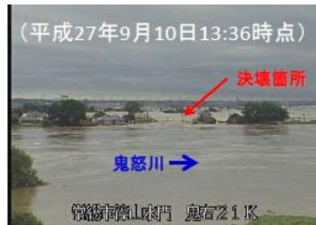
被災状況(対岸より撮影)
