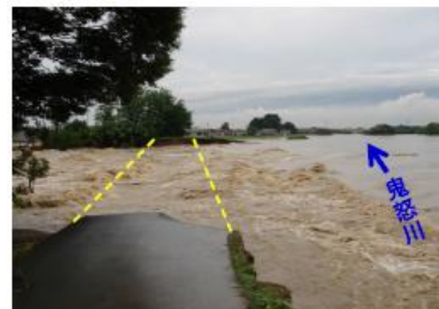
被災状況(拡大写真)
