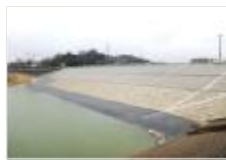
老朽ため池の改修
