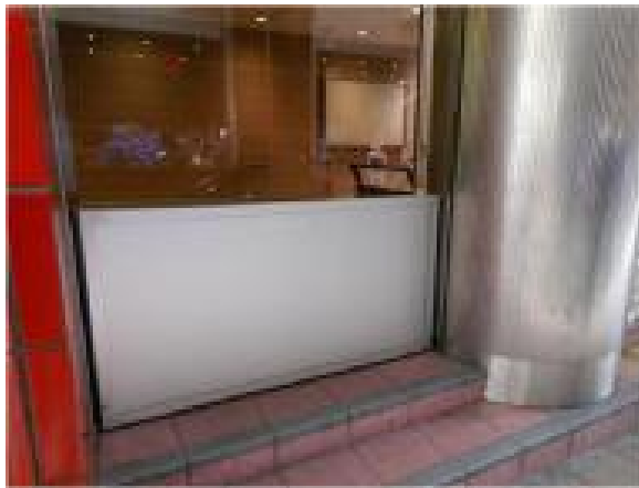
止水板の設置事例
