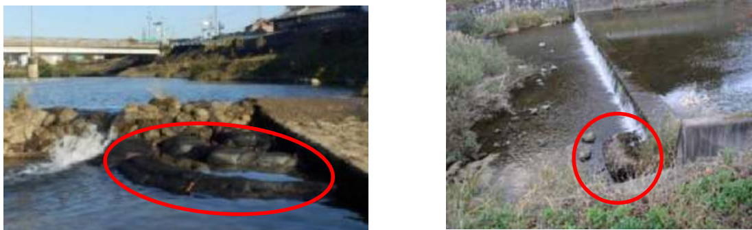
図-2.4 土のうやふとんかごによる簡易的な魚道のイメージ図
