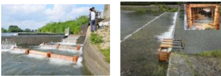
木積み階段斜路複合式魚道
