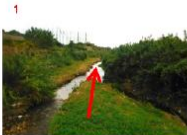
めいじこぼし 明治小橋下流
