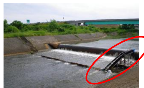
ファブリダムに設置された仮設式階段魚道
