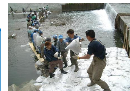
土のうによる簡易魚道の整備
