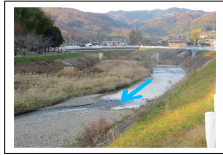
写真② 中流部（正恩寺橋下流付近）
