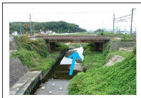
写真③ 下流部 (檜尾川橋下流付近)
