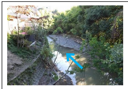
写真② 中流部 (谷川橋下流付近)
