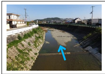
写真④ 下流部 (水無瀬橋下流付近)
