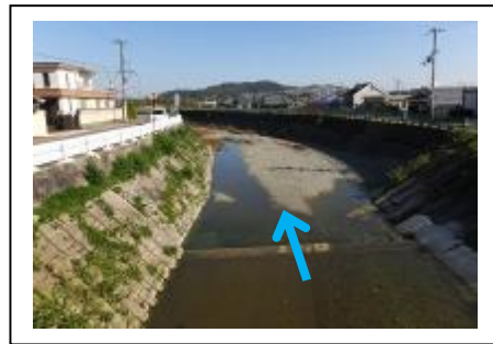
写真④ 下流部 (水無瀬橋下流付近)
