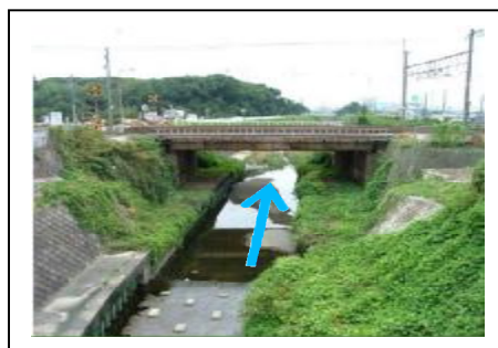
写真③ 下流部 (檜尾川橋下流付近)
