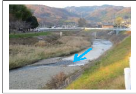
写真② 中流部（正恩寺橋下流付近）
