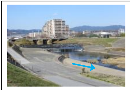
写真③ 下流部（JR 芥川橋梁下流付近）
