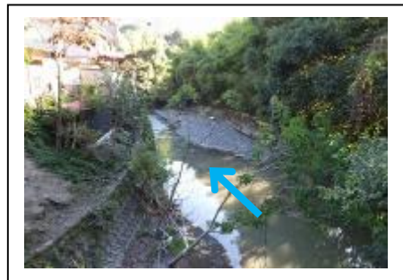
写真② 中流部 (谷川橋下流付近)
