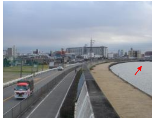
写真 1.4 防潮堤状況 (神崎川：左門殿川分派後)
