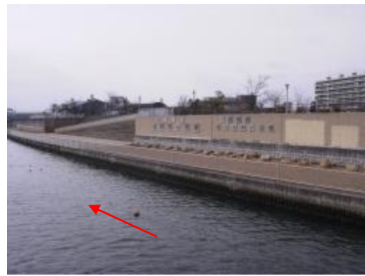
写真 1.6 佃防災船着場 (神崎川：神崎大橋下流)
