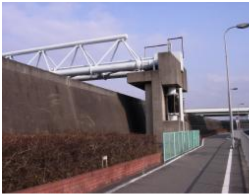
写真 1.5 防潮堤状況 (神崎川：出来島大橋下流)
