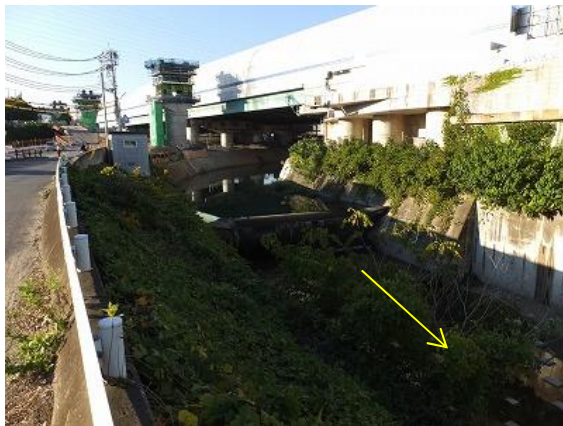
檜尾川の取水堰
