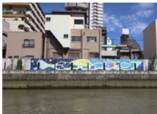
図-1.14 木津川ウォールペインティング （河川側から作品を鑑賞できる）
