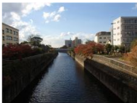
図-1.17 住吉川水門上流側
