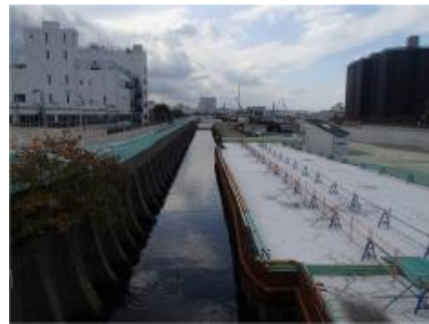
図-1.24 北港新橋下流
