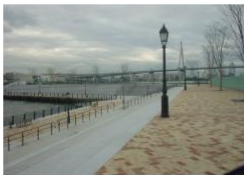
図-1.11 あじがわ 安治川スーパー堤防区間
