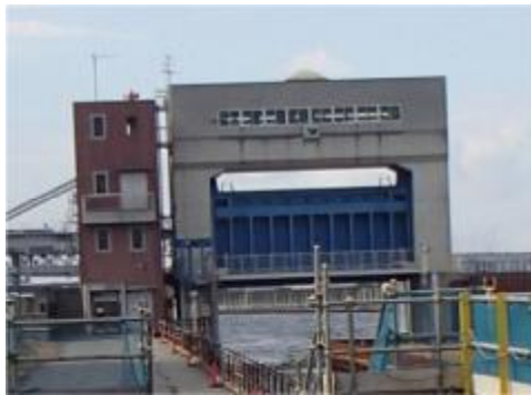
図-1.23 しょうれんじがわ 正蓮寺川水門
