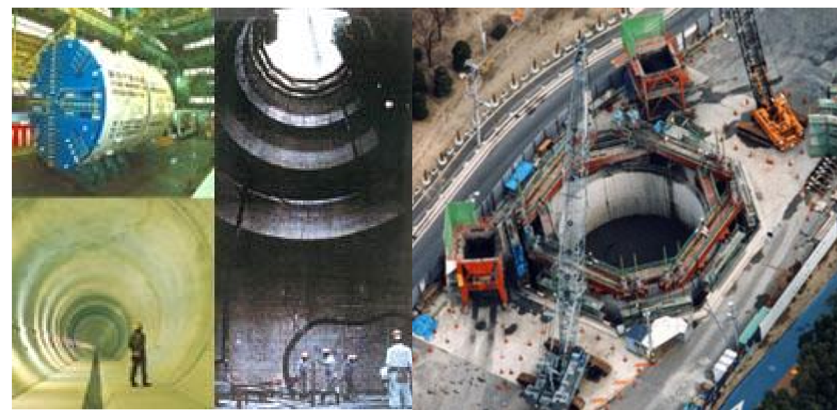
図 1.75 淀の大放水路の建設状況
