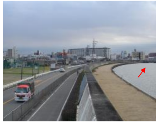
写真 1.4 防潮堤状況 (神崎川：左門殿川分派後)
