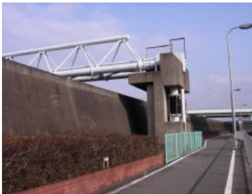
写真 1.5 防潮堤状況 (神崎川：出来島大橋下流)
