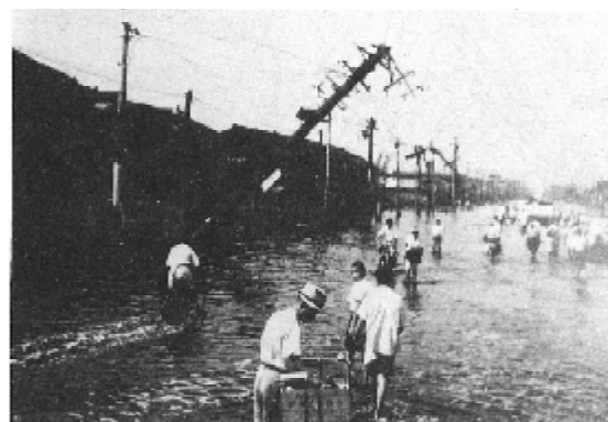
写真 1.1 浸水状況 (国道 2 号)
