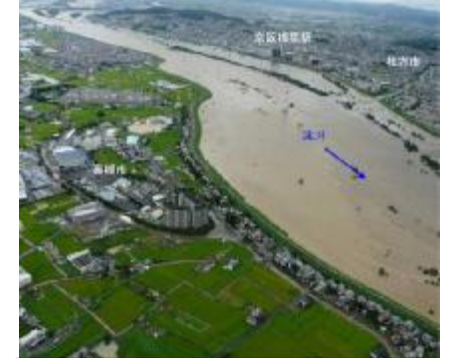
高水敷が冠水した淀川 (平成25年9月台風18号洪水の概要より)
