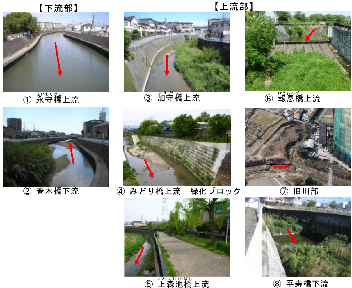
図 - 1.2 春木川河道状況
