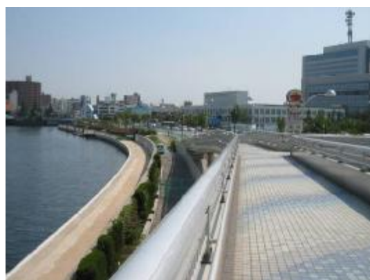
図-1.13 木津川・尻無川スーパー堤防区間
