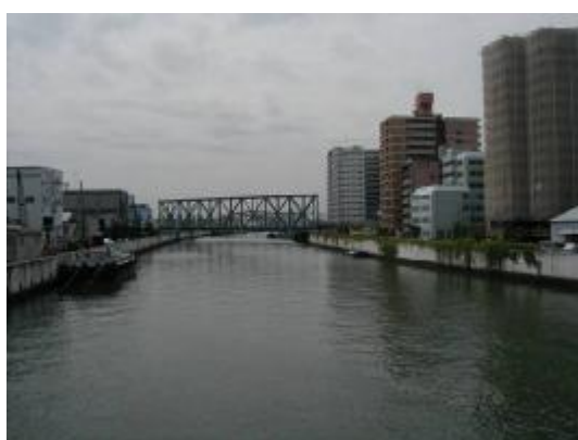
図-1.12 木津川（尻無川分派点上流）
