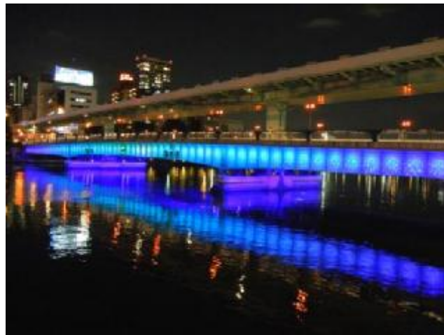
図-1.29 天満橋（橋梁のライトアップ）
