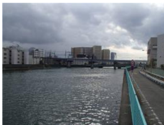
図-1.26 北港通下流
