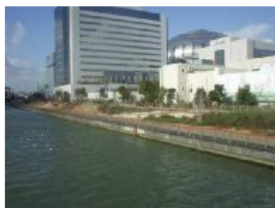
図-1.15 木津川・尻無川スーパー堤防区間
