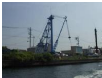
図-1.16 尻無川水門上流（左岸）
