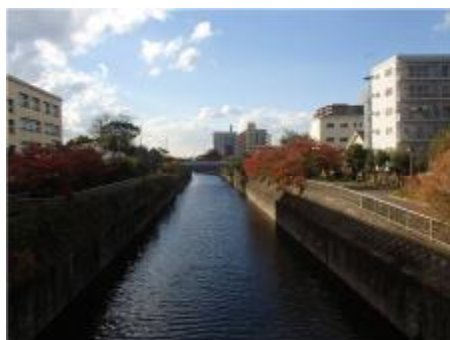
図-1.17 住吉川水門上流側
