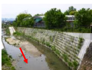
④ みどり橋上流 緑化ブロック
