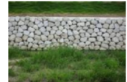
粗面ブロックを用いた護岸
