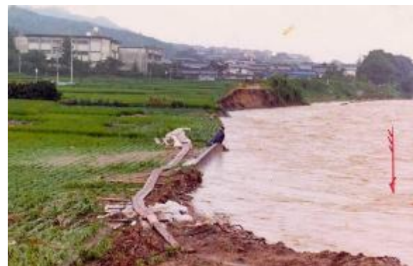
石川昭和橋上流右岸 （昭和57年）
