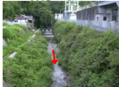
写真④ 石見川（上之宮橋付近）
