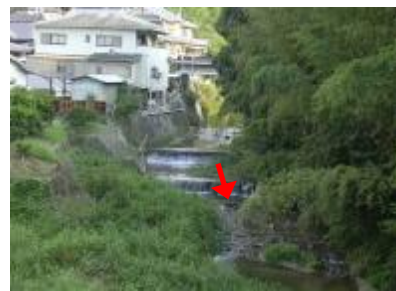
写真③ 千早川 (千早大橋付近)
