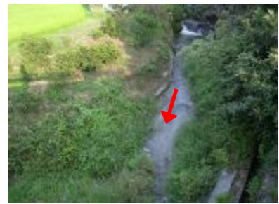
写真④ 水越川 (楠木橋付近)
