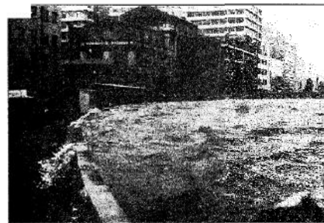
第二室戸台風 中之島 土佐堀川左岸
