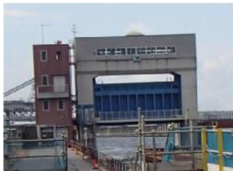
正蓮寺川水門
