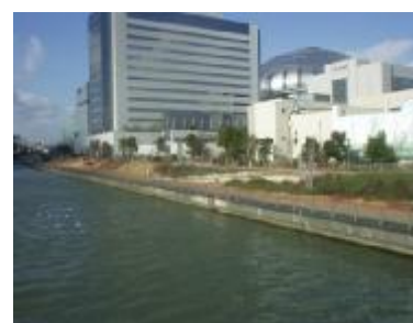
尻無川スーパー堤防区間（尻無川右岸）
