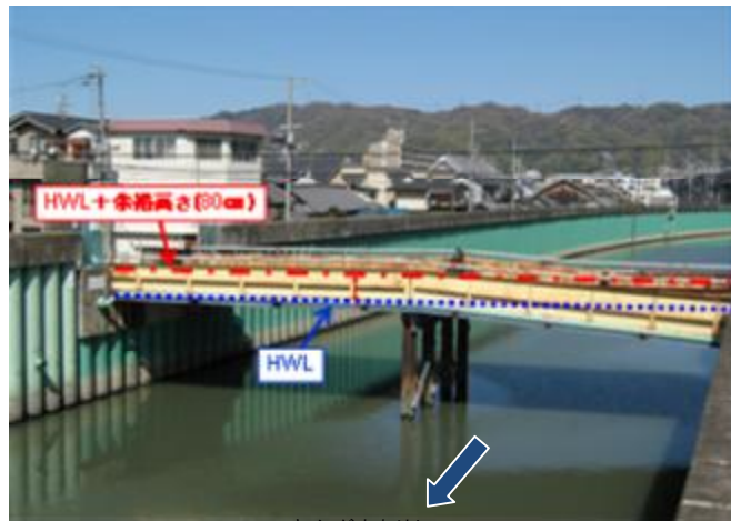
図 2.3 三箇大橋の現況
