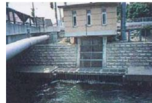
写真 1.8 古川浄化導水路流入部
