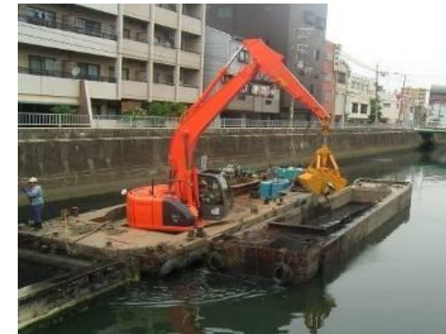
写真 1.6 底質汚泥の浄化浚渫(平野川)
