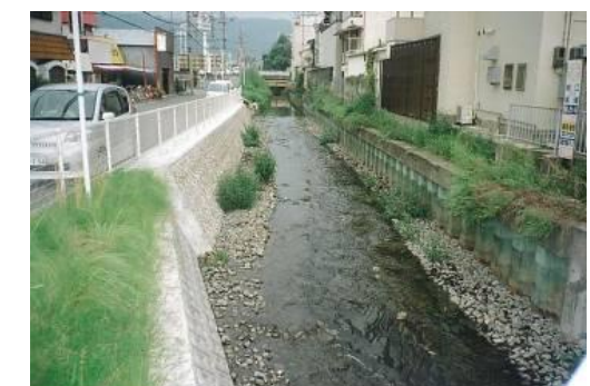
写真 1.9 多自然浄化(平野川)
