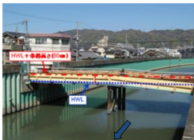
図 2.3 三箇大橋の現況
