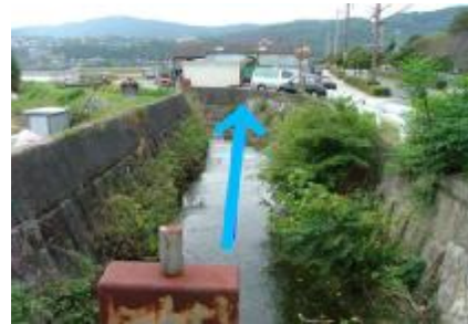
②無名橋から下流を見る
