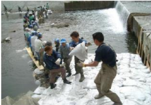
土のうによる簡易魚道の整備
