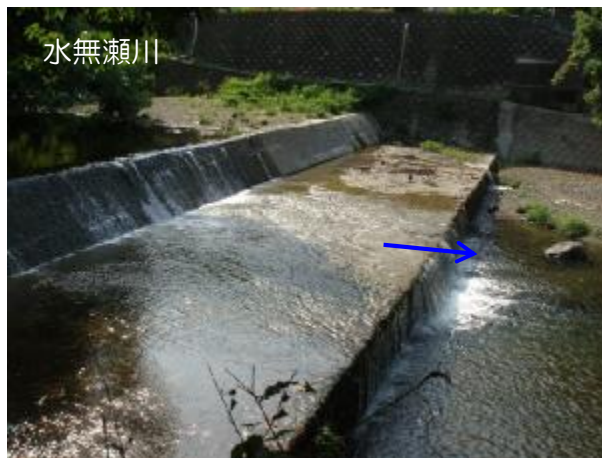
水無瀬川 落差工(魚道なし)
