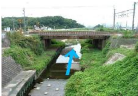
① 檜尾川橋より下流を見る
