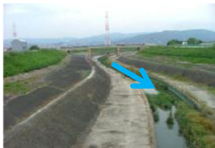
② 演習橋より上流を見る。
