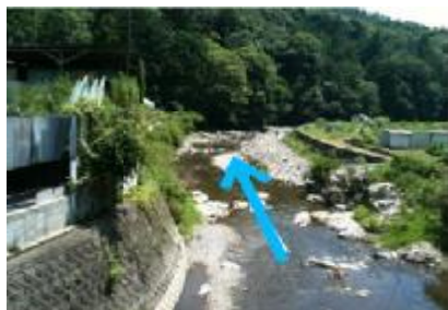
①摂津峡大橋付近より下流を見る
