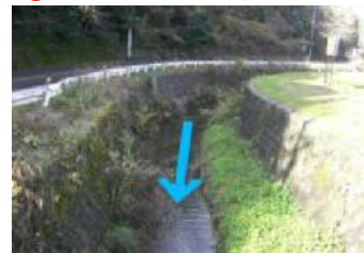
③無名橋から上流を見る
