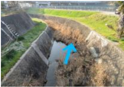
②氷室橋より上流を見る
