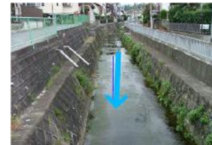
③無名橋から上流を見る
