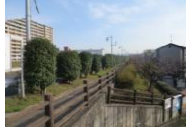
④高槻橋右岸側 遊歩道が整備
