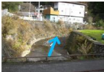
①無名橋より下流を見る
