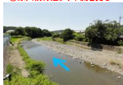
④原大橋付近より下流を見る
