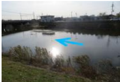
③高槻橋左岸付近より下流を見る
