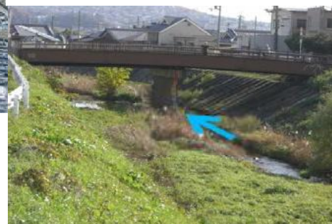
④水無瀬橋上流より下流を見る
