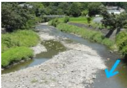
②大森橋～千原橋(上流を見る)
