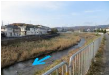
②正恩寺橋付近より上流を見る
