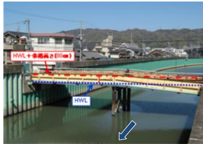
図 2.3 三箇大橋の現況
