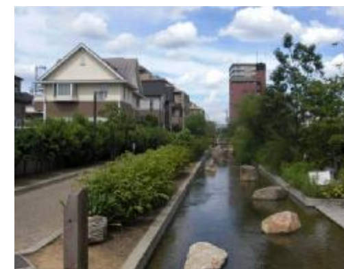
写真 1.10 下水の高度処理水の導入事例(東大阪市)
