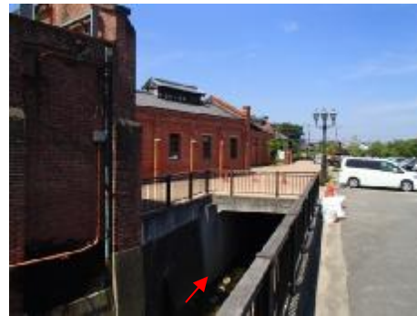
⑧煉瓦館付近
