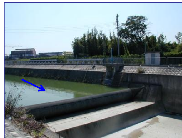
横断工作物による瀬切れ薬師井堰(西除川)
