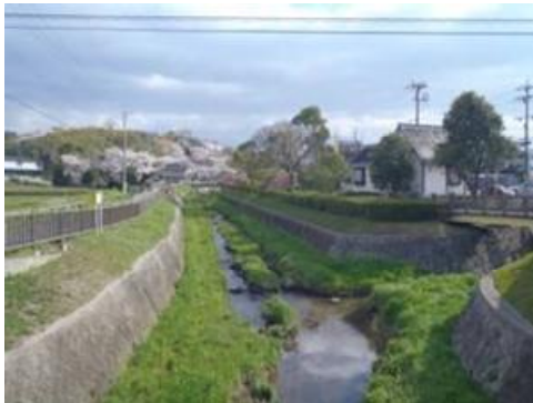
図-1.4 三津屋川の河道状況
