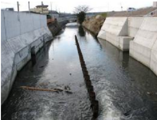
図-1.7 落堀川の河道状況
