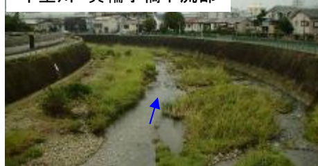
千里川 箕輪小橋下流部
