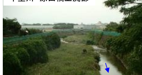
千里川 原田橋上流部
