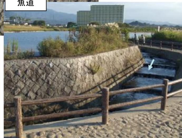
魚道のある例: 嶋井堰(石川, 可動堰化済み, 魚道設置済み)
