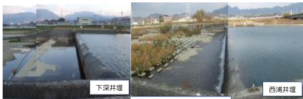
数多くある井堰により瀬切れが発生
