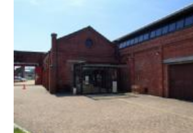
熊取交流センター煉瓦館
