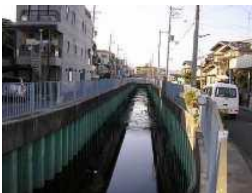
図 1.6 狭間川 (西除川合流点～小今池橋下流)
