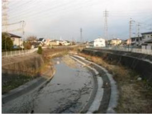
図 1.2 西除川 (大和川合流点～南海高野線)
