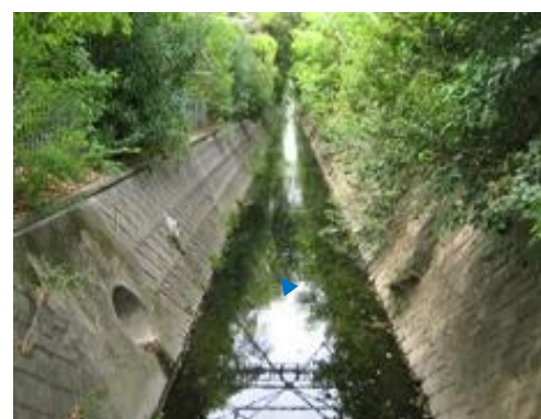
図 1.7 狭間川 (小今池橋上流～府道大阪中央環状線)
