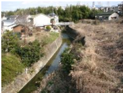
図 1.4 西除川 (狭山池ダム上流)
