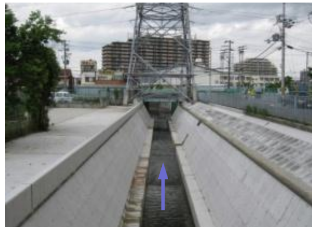
鉄塔部【1/10 整備済(河床掘削)】
