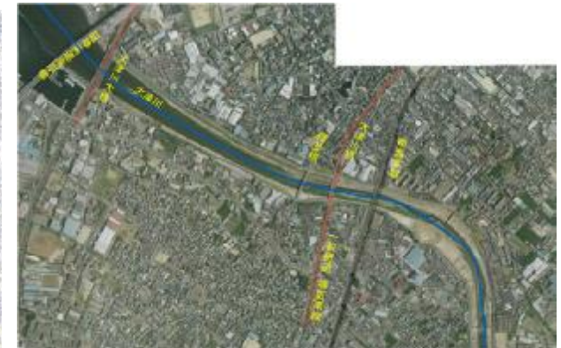
大津川下流部の状況
