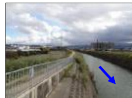
9. 前川橋付近（松尾川下流部）
