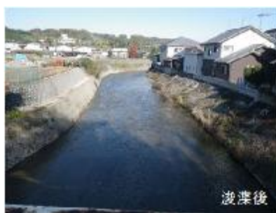
堆積土砂の撤去
