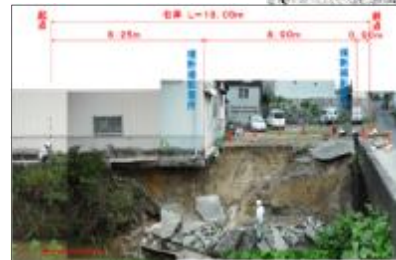
4. 松尾川冬堂橋下流右岸（和泉市春木町）
