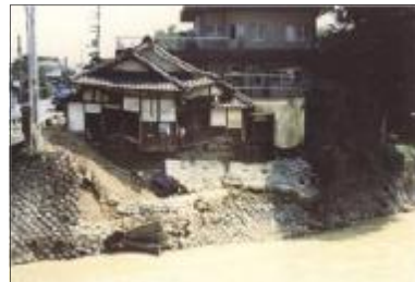
2. 槇尾川川中橋下流（和泉市三林町）
