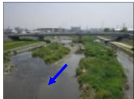
1. 橋並橋上流（大津川）
