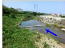
3. 上川橋付近（榎尾川中流部）
