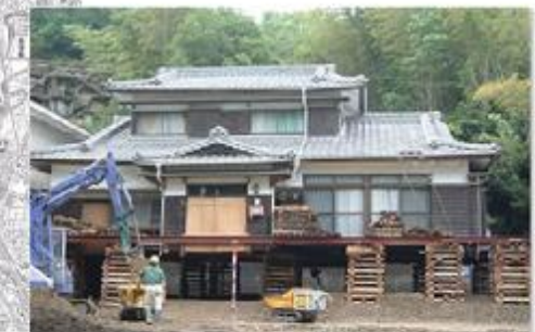
宅地嵩上げ・ピロティ
