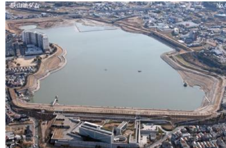
現在の狭山池ダム (平成21年)
