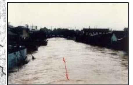
西除川(新布忍橋より下流)S57.8
