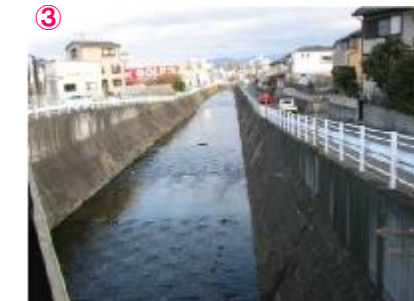
③ 東除川（新伊勢橋より上流） 両岸コンクリートブロック護岸の人工的な様相の直線河道です。部分的に砂州等が形成されています。
