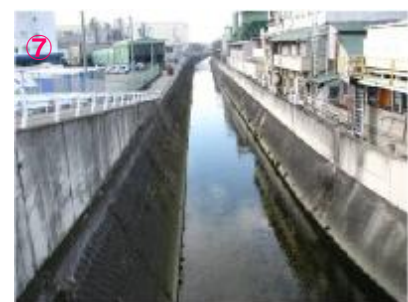
⑦ 落堀川（大正橋より下流） 両岸コンクリートブロック護岸の人工的な様相です。
