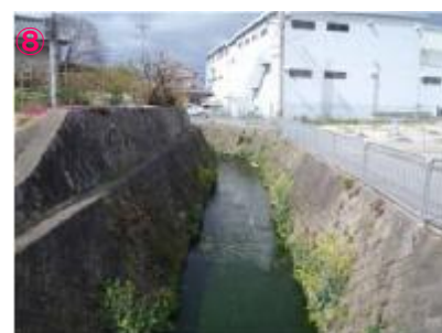
⑧ 平尾小川（無名橋より下流） コンクリート三面張り水路で改修され人工的な様相です。
