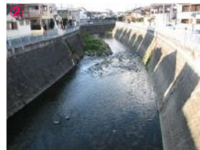
② 東除川（一津屋橋より下流） 両岸コンクリートブロック護岸で人工的な様相です。堰が多く、部分的に砂州等が形成されています。
