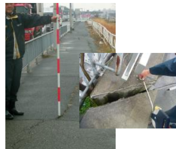
図 2.2.3 河川巡視の状況
