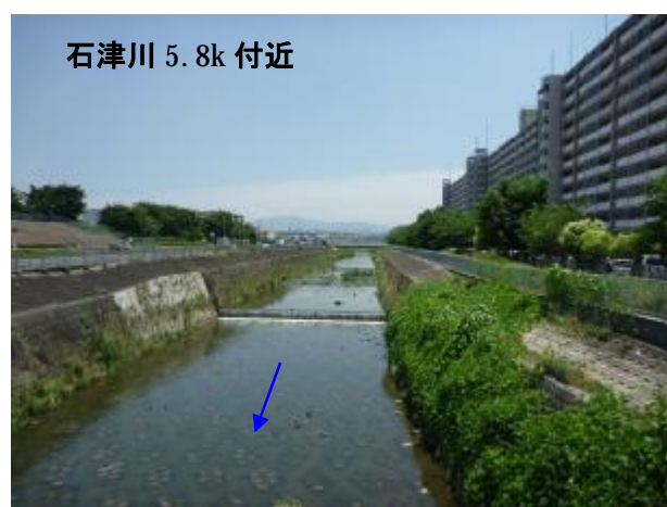
図 1.2.8(2) 万崎橋上流の状況（石津川）
