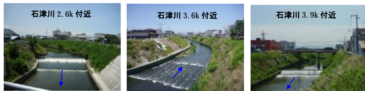
図 1.2.13 石津川の堰や落差工
