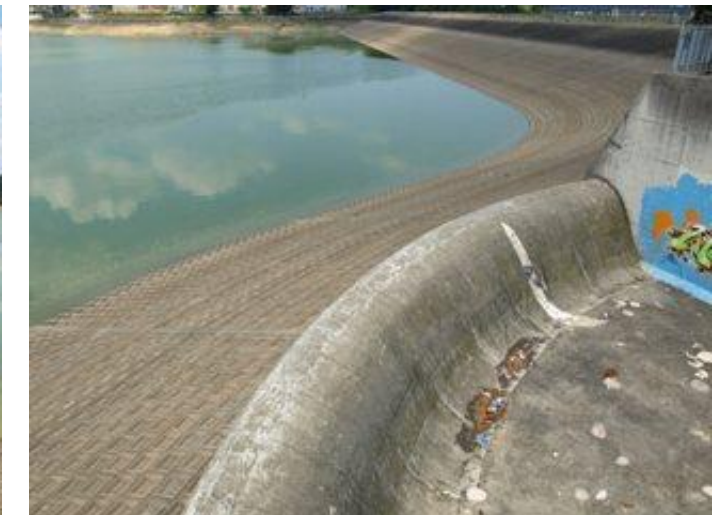
図 1.1.8(5) 洪水吐き（甲斐田川の水源地）
