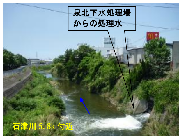
図 1.2.8(1) 万崎橋下流の状況（石津川）
