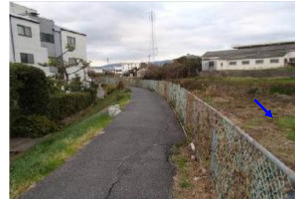
佐野川の下流区間の状況 （築堤区間：佐野川橋上流）
