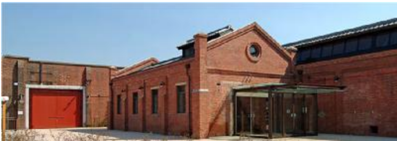
煉瓦館(紡績工場跡)
