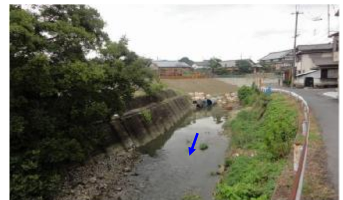
佐野川の上流区間の状況 （国道26号付近）
