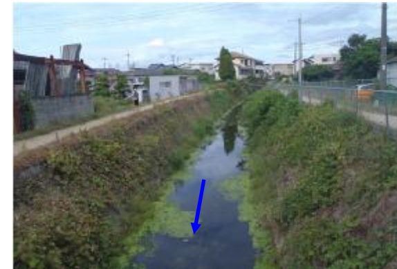
雨山川の上流区間の状況 （豊穰橋下流の橋上流付近）
