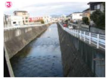
③ 東陸川（新伊勢橋より上流） 両岸がコンクリート3面貼りの護岸が人工的な様相の掘込河川です。一部の河川沿いに緑地帯が形成されています。
