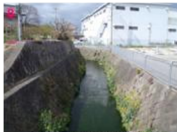
⑧ 平尾小川（豊名橋より下流） コンクリート3面貼りの水路が典型的な人工的な様相です。
