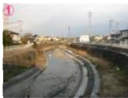
① (狭間小橋より上流) 両岸コンクリートブロック護岸です。低水時整備を行った河断面で遊歩道も整備されています。遊歩道が埋め込まれた砂州により圧迫感を解消しています。
