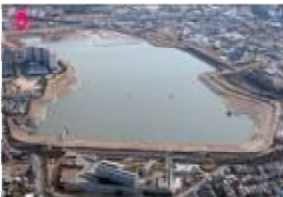
⑤ (彈山池ダム) 土質工事が完了し、操池や遊歩道の創設した周辺整備を実施しています。
