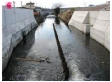
⑥ 尾堀川（西橋より上流） 両岸がコンクリート3面貼りの護岸が人工的な様相です。
