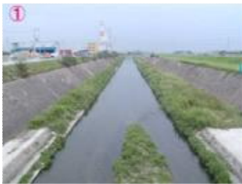
① 東陸川（明名新橋より下流） 両岸がコンクリート3面貼りの護岸が人工的な様相ですが、右岸側は遊歩道を兼ねた緑地帯と水面見出しが見えています。
