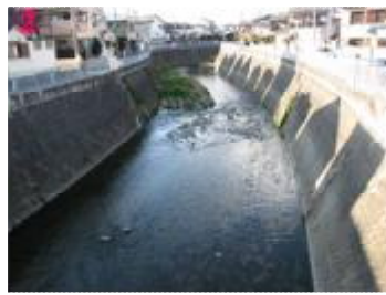
② 東陸川（一津區橋より下流） 両岸がコンクリート3面貼りの護岸が人工的な様相ですが、一部の河川沿いに緑地帯が形成されています。
