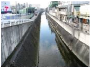
⑦ 尾堀川（寺正橋より下流） 両岸がコンクリート3面貼りの護岸が人工的な様相です。
