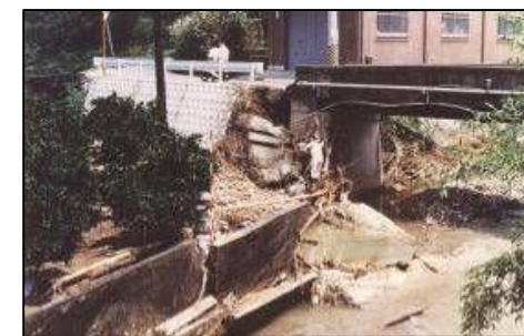
槇尾川地蔵橋(和泉市坪井町)
