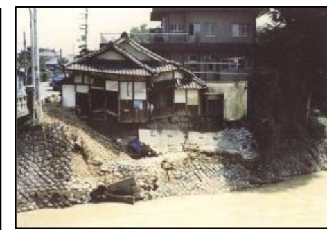
槇尾川川中橋下流(和泉市三林町)
