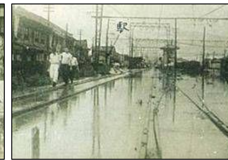
南海泉大津駅構内(泉大津市)
