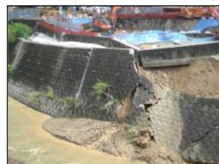
松尾川(箕形橋～唐国橋)
