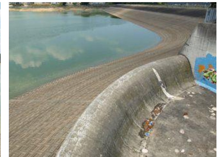
図 1.1.8(5) 洪水吐き（甲斐田川の水源地）
