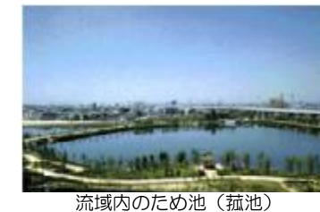
流域内のため池（菰池）
