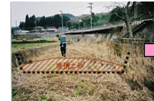
土砂堆積状況(除去前)
