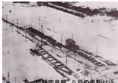
近鉄奈良線 八戸の里駅付近
