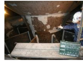
ポンプ精密点検
