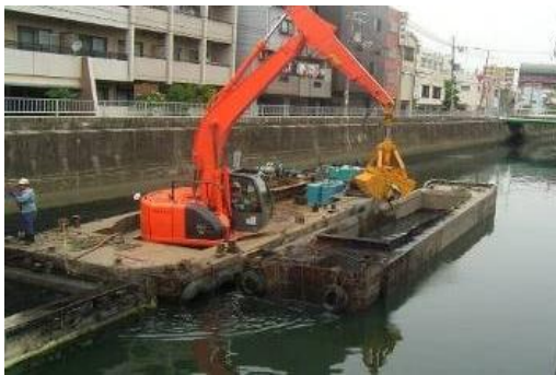
底質汚泥の浄化浚渫(平野川)
