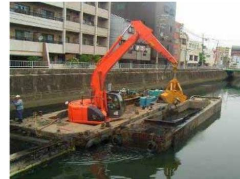
写真 1.6 底質汚泥の浄化浚渫(平野川)
