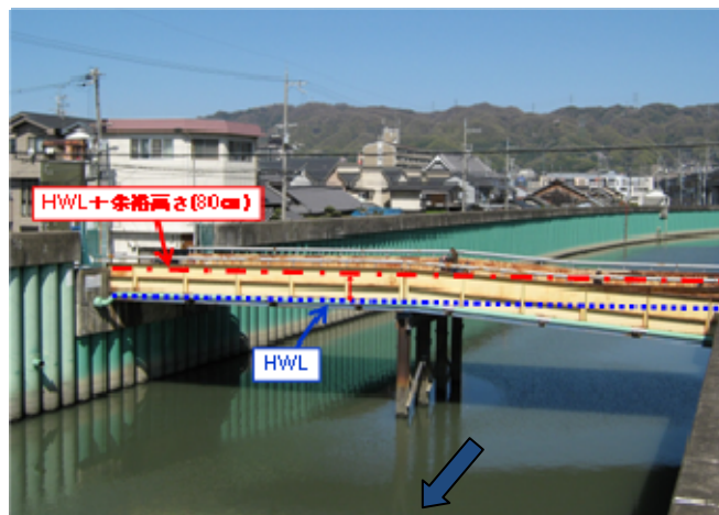
図 2.3 三箇大橋の現況
